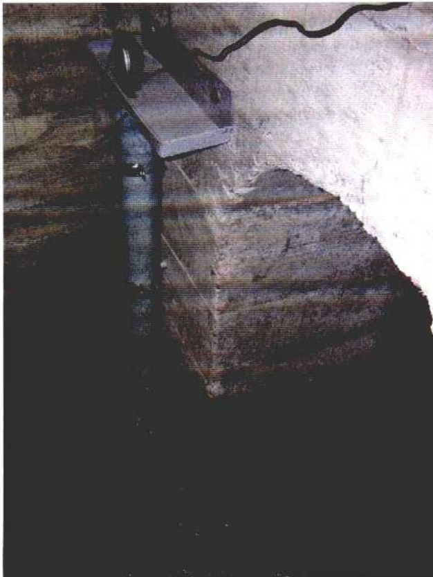
CODIFICADOR ANGULAR PARA EL REGISTRO DE CAUDAL EN LA CONDUCCIÓN DE ABASTECIMIENTO
