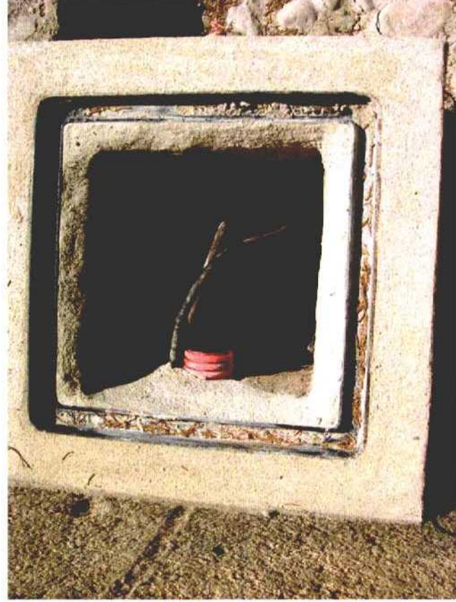
ARQUETA FINAL DE CABLE DE SEÑALES
