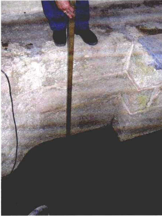
SISTEMA DE MEDIDA DE CAUDAL MEDIANTE ESCALA MANUAL UTILIZADO EN LA CONDUCCIÓN DE ABASTECIMIENTO
