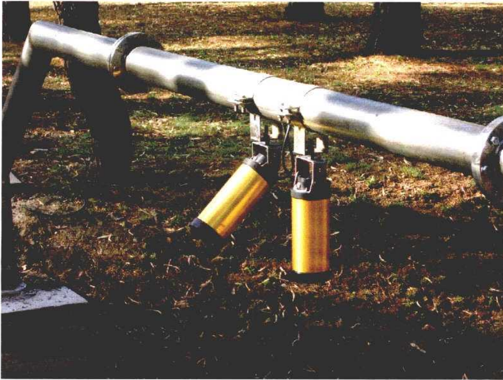
RADARES DE NIVEL Y VELOCIDAD DEL AGUA
