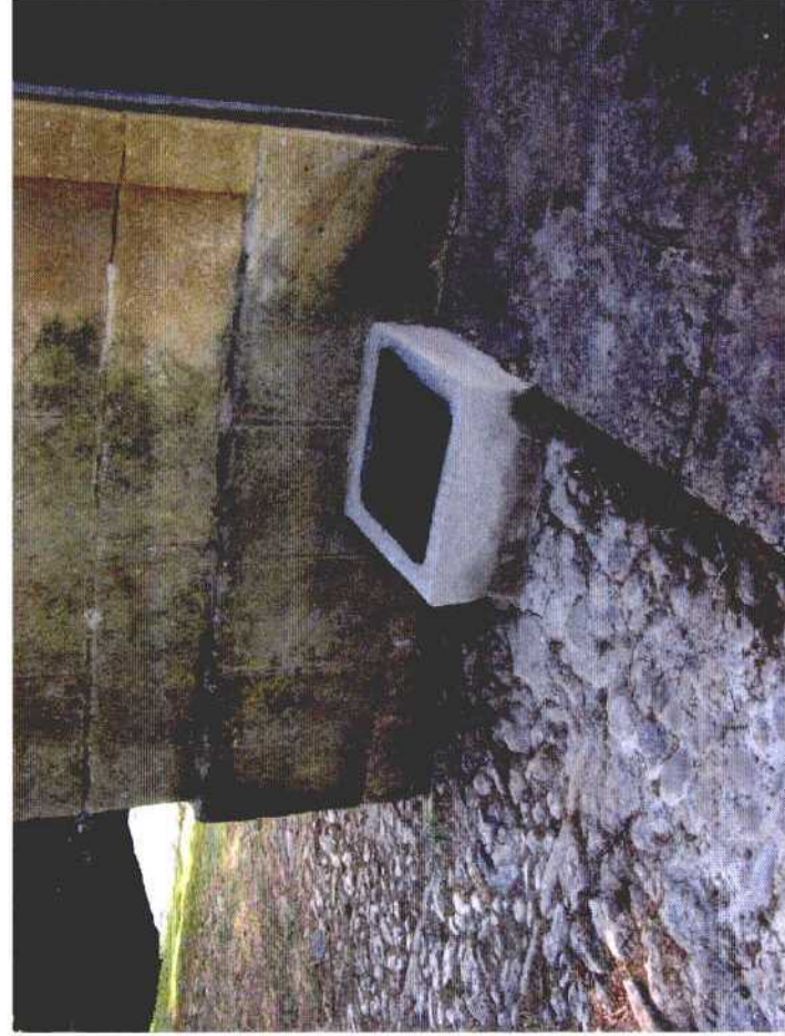
ARQUETA FINAL DE CABLE DE SEÑALES
