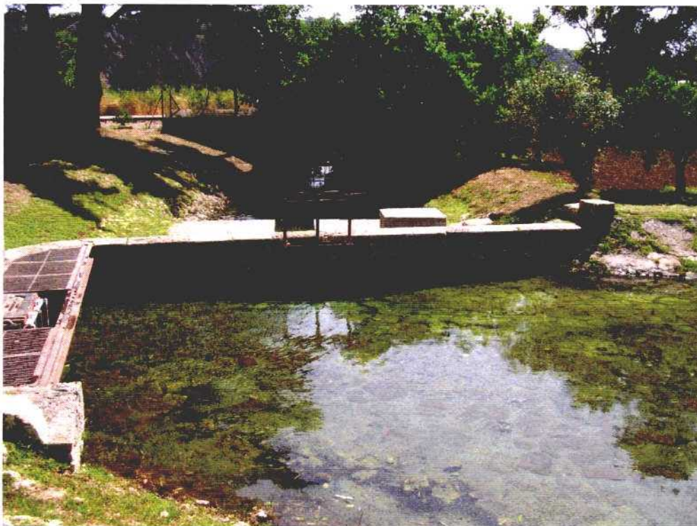
COMPUERTA PARA LA DERIVACIÓN DEL AGUA SOBRANTE ANTES DE LA CONDUCCIÓN DE ABASTECIMIENTO
